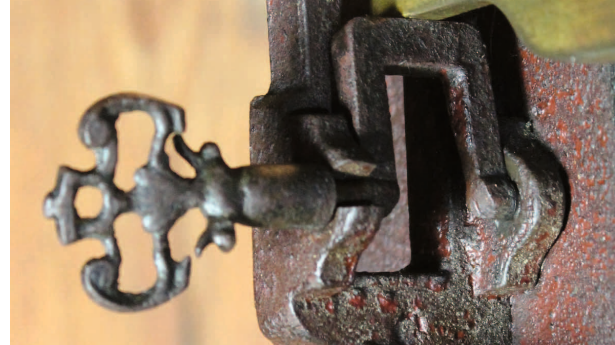
Abb. 7: Balkenarretierung mit Achse zum Münzkasten
