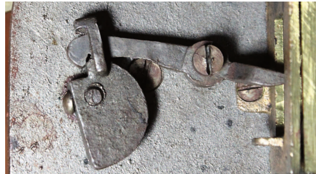
Abb. 8: Sperrhebel verhindert Drehung
